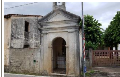
Il capitello che sarà spostato: la casa è già stata abbattuta
