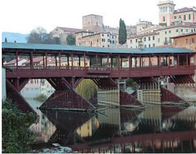
Il Ponte degli Alpini | I lavori continuano per il consolidamento dell'opera
